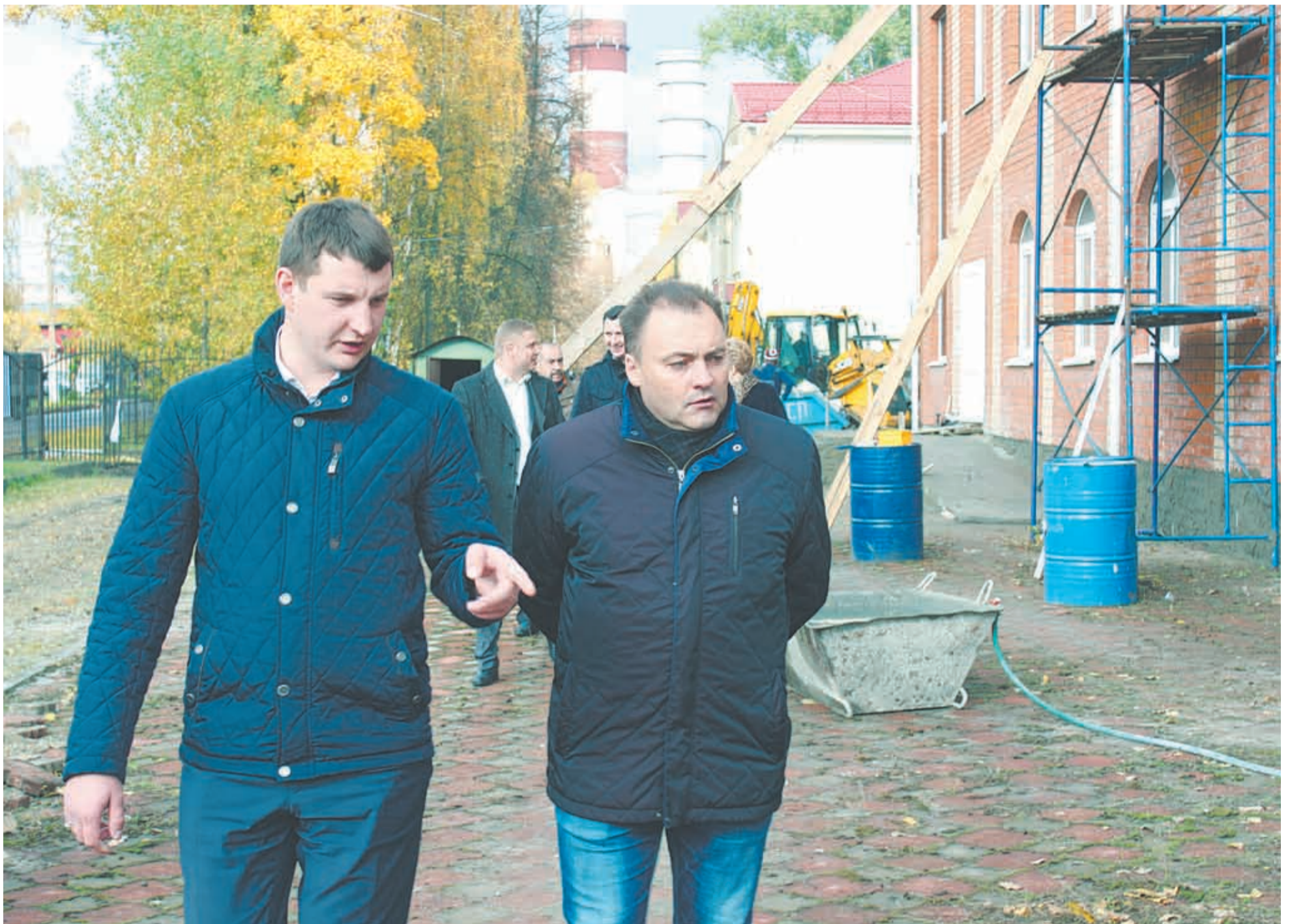
Глава города Денис Семенов и директор подрядной организации "Стройинжиниря" Виталий Паламарчук обсудили ход работ по капремонту детской поликлиники. | ФОТО О.БАШКИРЕВОЙ, "ЭВ"
